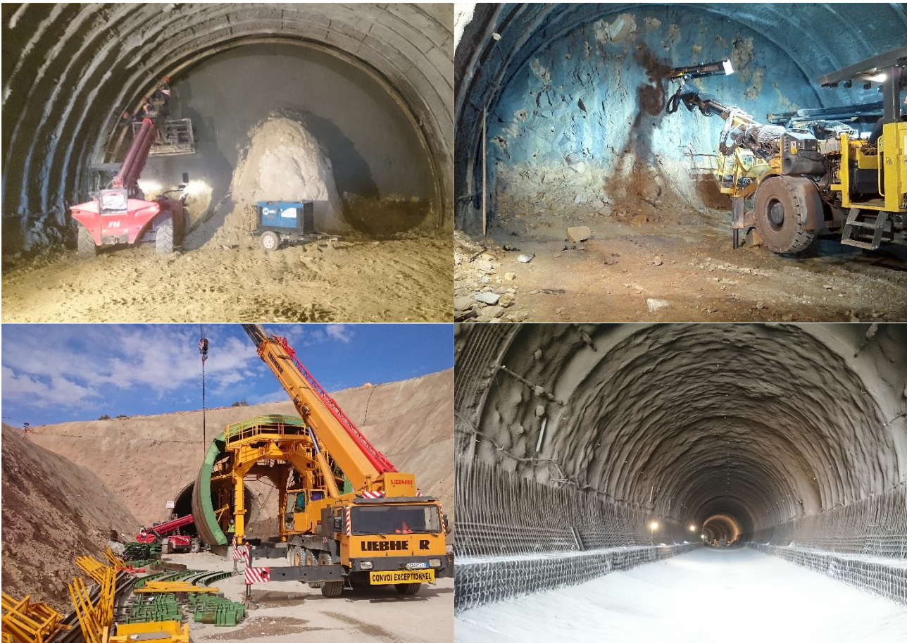
Figura 10 - Aspectos diversos da fase construtiva. Em cima à esquerda, escavação em ZG3 em areias da unidade Cn-Cretácico médio no túnel T2, com faseamento simplificado em duas fases horizontais. À direita furação para avanço da frente na unidade Ct- Cretácico superior no túnel T2. Em baixo posicionamento da cofragem junto à saída do túnel T2 e aspecto do túnel T2, com a contrabóbada e armaduras da base dos passeios/caleira de equipamentos e de arranque da abóbada instaladas. Imagens cedidas pela COSIDER-TP
